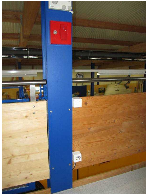
Bild 2: Lage der Steckdose neben dem Waren-aufzug
