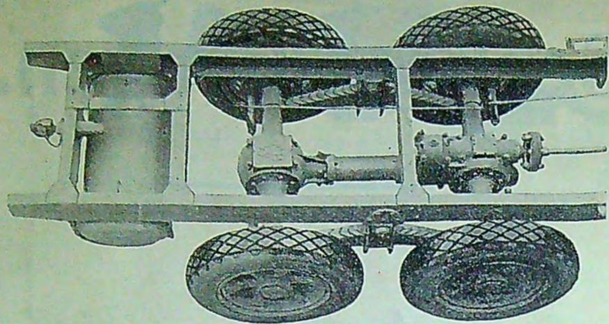
F. B. W.-Sechsräderwagen. Die beiden Hinterachsen mit ihrem Antrieb und der Federaufhängung.
