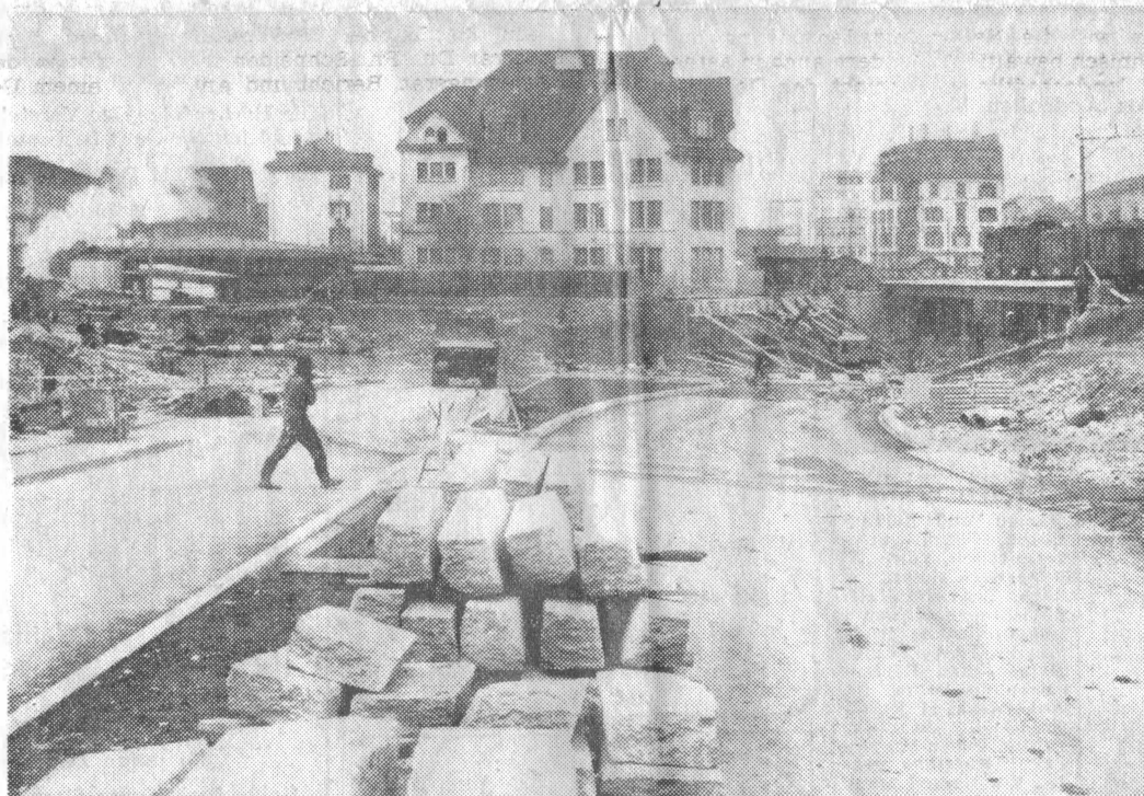
In einer Kurve (vom rechten zum linken Bildrand) führt die neue Gießhübelstraße unter der Sihltalbahn durch stadtauswärts. Im oberen Teil sind die Tramgleise bereits einbetoniert. Vorn im Bild zweigt die richtungsgetrennte neue Allmendstraße nach der Brunau ab.
