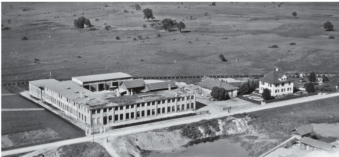
FBW an der Motorenstrasse 100 in Wetzikon ZH, 1928.
